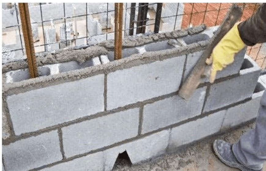
Imagem 02 – Acabamento em alvenaria estrutural.
