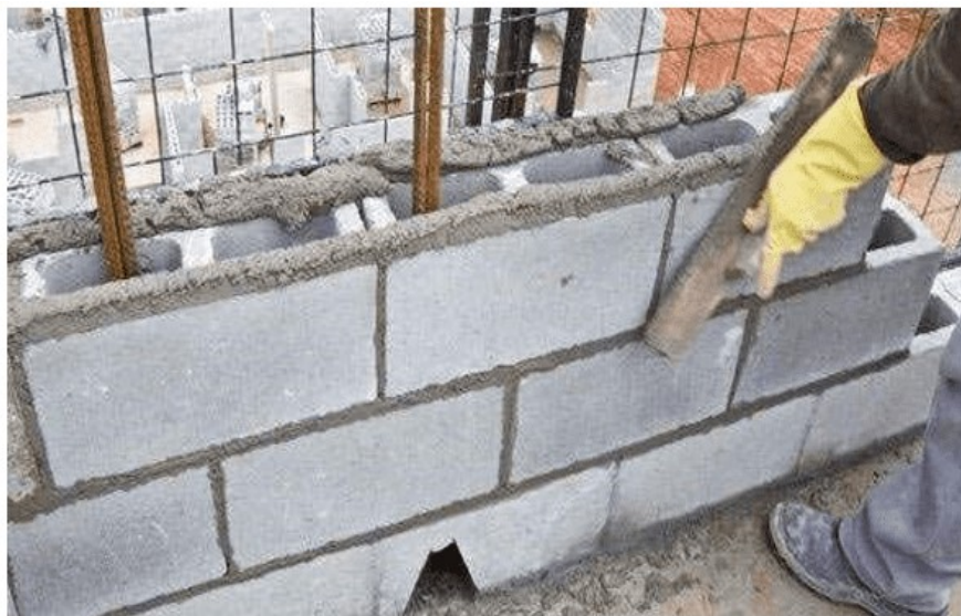
Imagem 02 – Acabamento em alvenaria estrutural.
