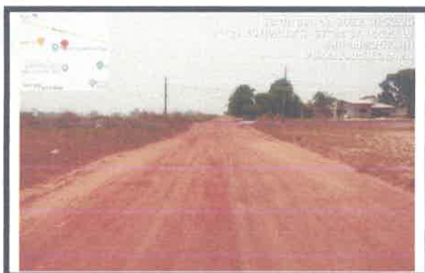
Foto 08: Avenida Passo Fundo.
