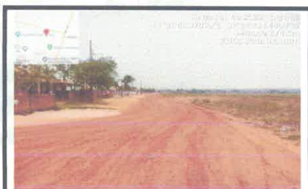
Foto 06: Avenida Passo Fundo.
